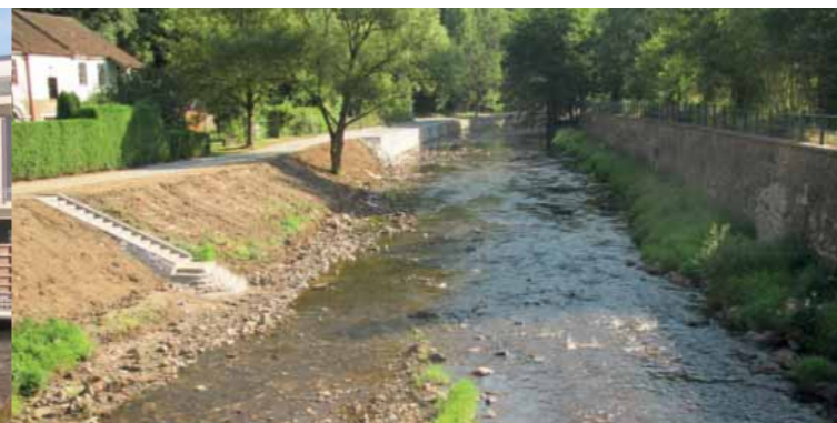
Mže v Pavlovicích – oprava břehových zdí
