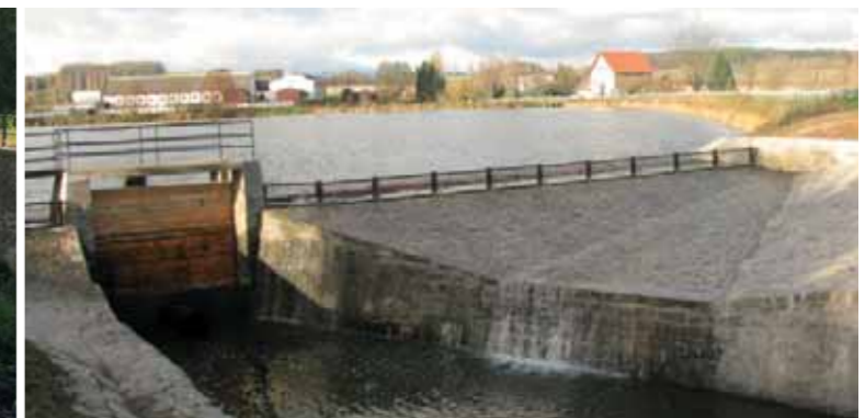
Nádrž Bílka na Záhořanském potoce – oprava přelivu
