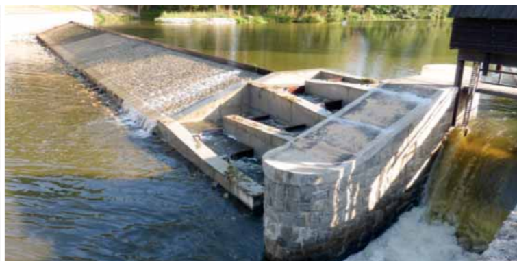
Nežárka v Horním Žďáru – rekonstrukce jezu
