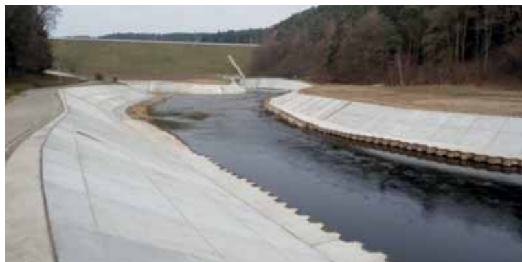
Vodní dílo Hracholusky – oprava opevnění odpadních koryt
