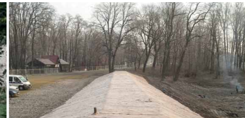
Ochranná hráz ve Veltrusích po opravě
