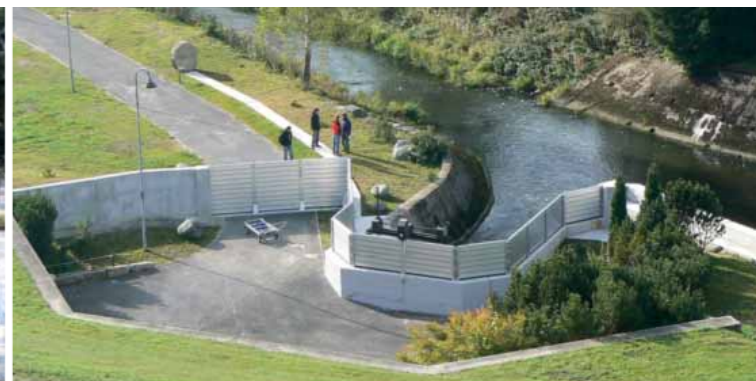
Vodní dílo Žlutice – protipovodňová ochrana
