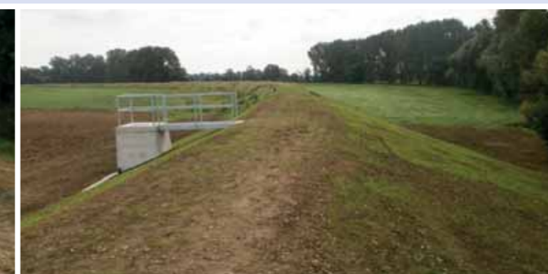
Ochranná hráz Vrbno – Zelčín – po odstranění škod
