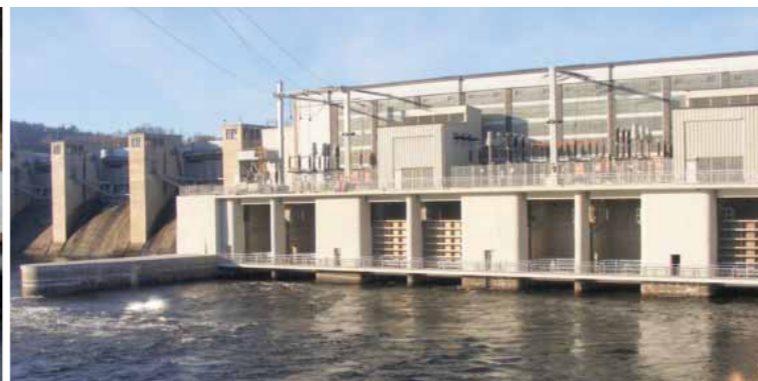
Vodní dílo Kamýk – sanace betonů u výtoků TG
