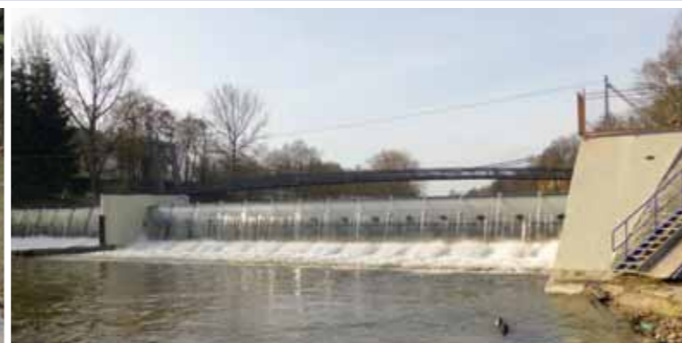
Pětikolský jez na Otavě – oprava levého jezového pole
