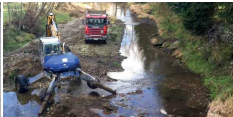
Otava v Žichovicích – odstraňování škod po povodni v červnu 2013
