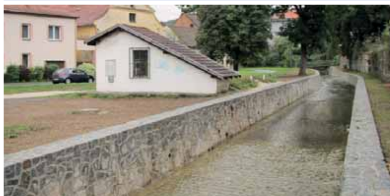
Losinský potok – oprava kamenných zdí
