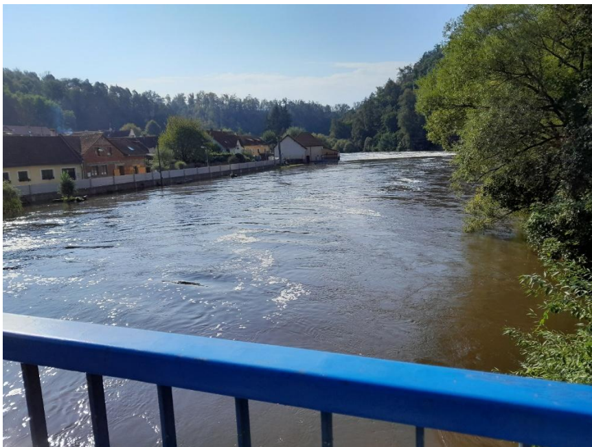
Obrázek 12 Bechyně – Zářečí, pohled z mostu krále Jana
