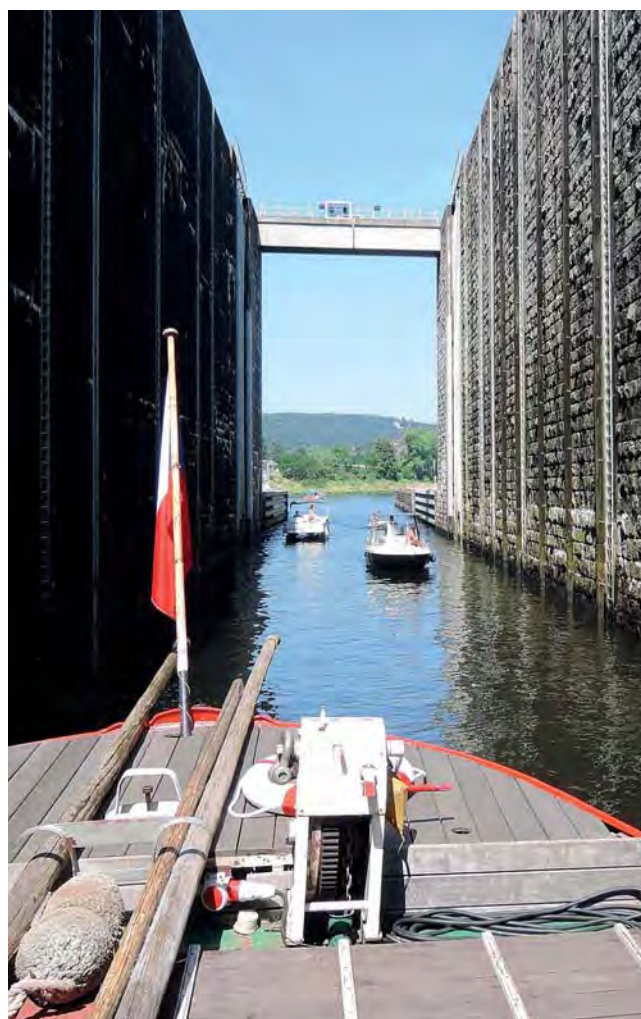
Vltava, VD Štěchovice, plavební komora
